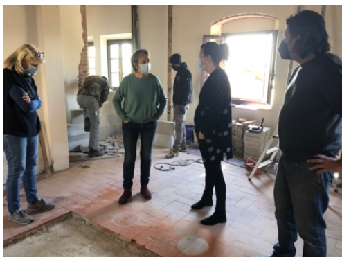
Renovering af "Mors hus"
